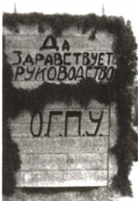
Лозунг на стене барака строителей Беломорско-Балтийского канала. 1932 г.
